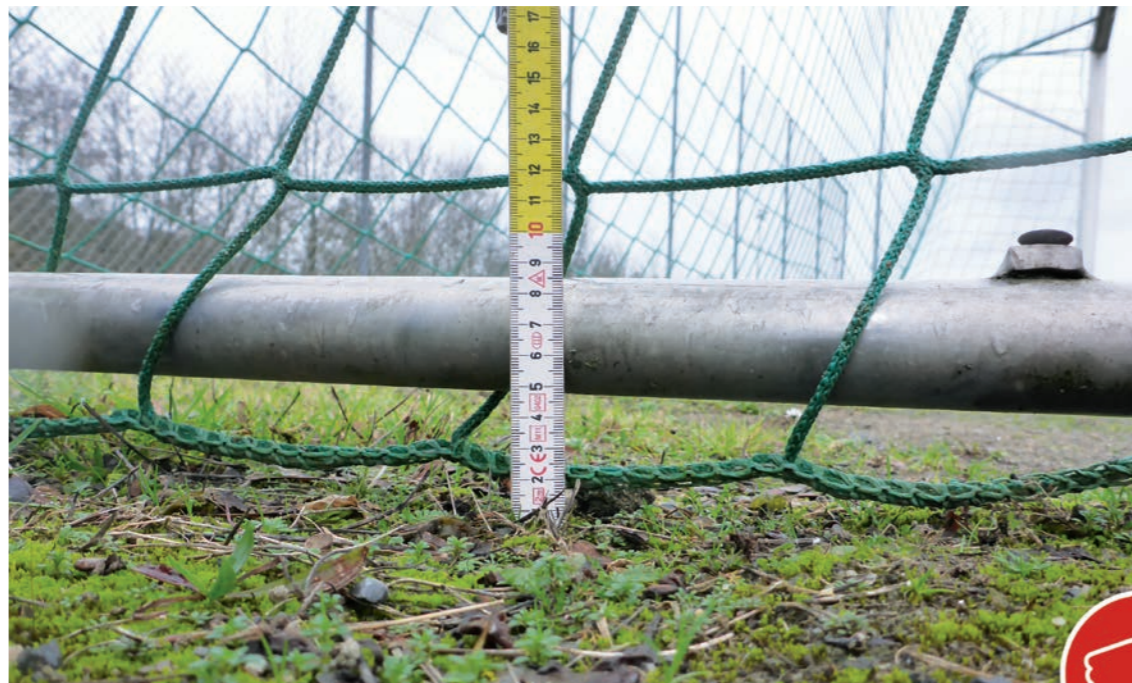
Bild 24: Höhendifferenz zwischen Bodenrahmen und Boden
