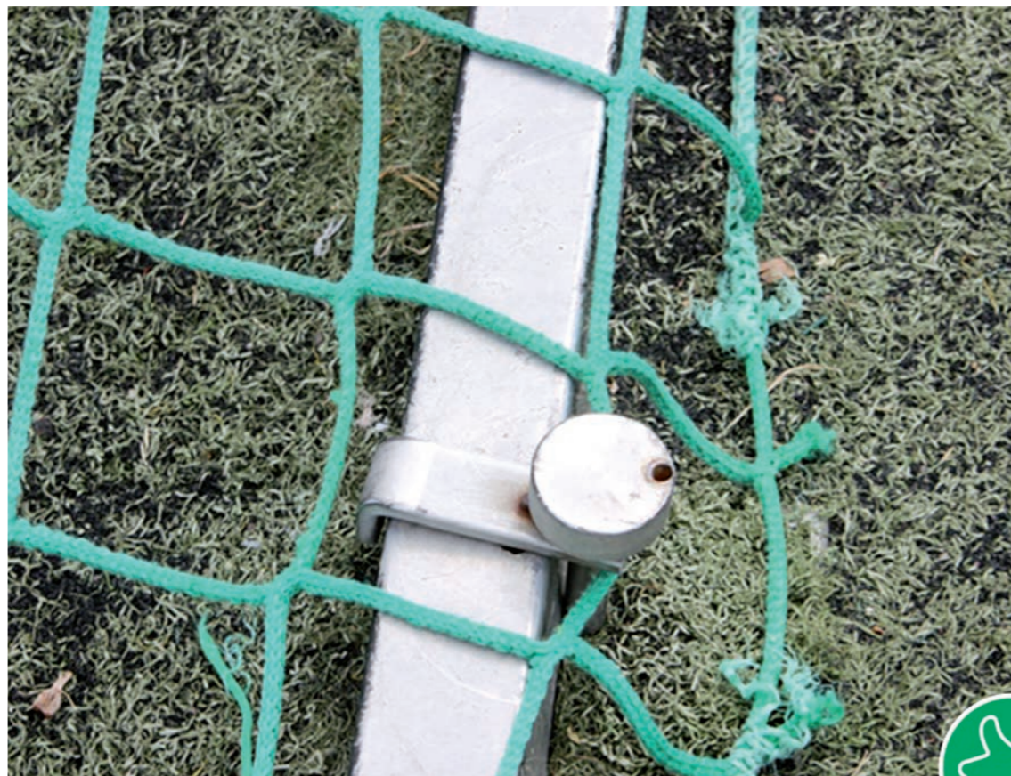
Bild 8: Befestigung mit Klemmbodenhülsen
