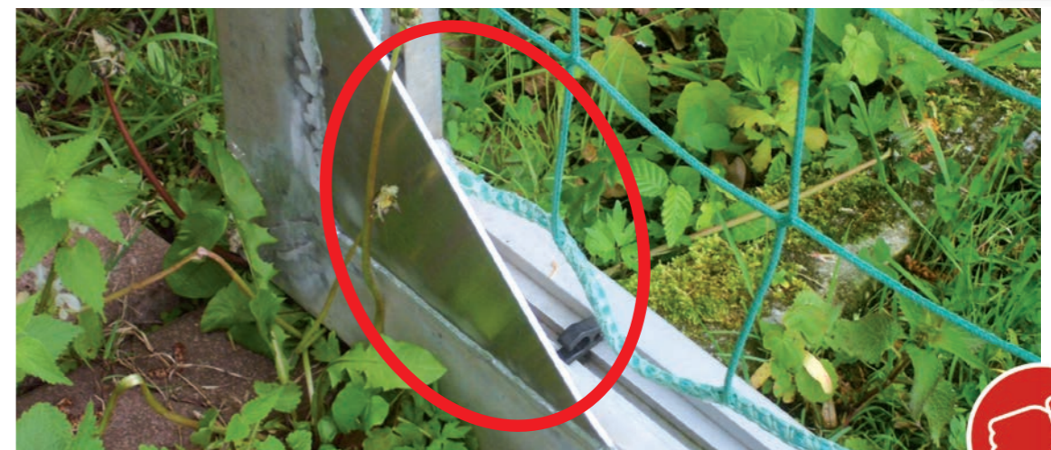
Bild 29a und 29b: Horizontal und vertikal eingeschweißte Winkel stellen erhöhte Verletzungsgefahren dar.
