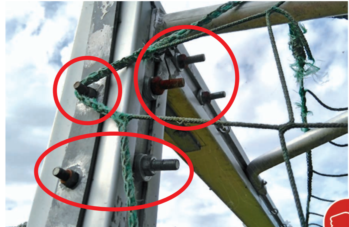
Bild 17: Überstehende Schrauben an Pfosten und Querlatte
