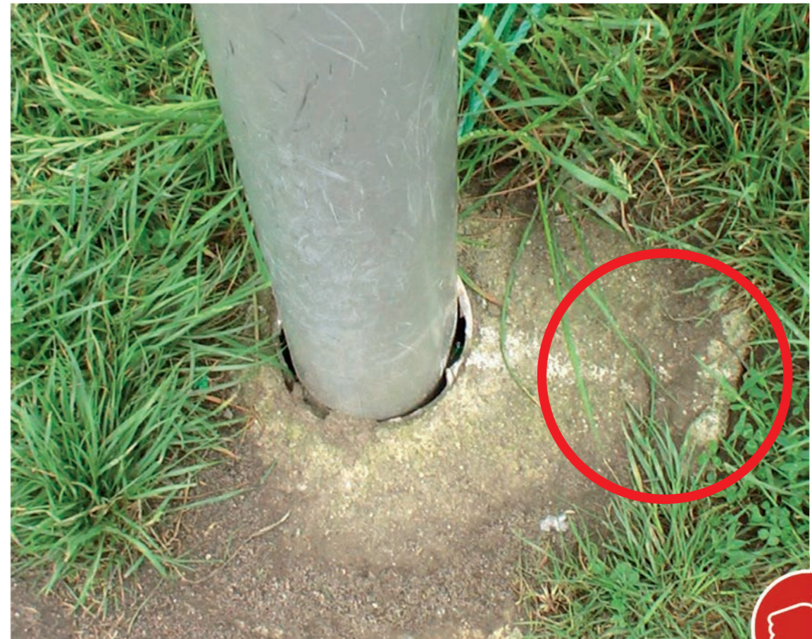
Bild 25: Fundamente sind mind. 4 cm zu überdecken
