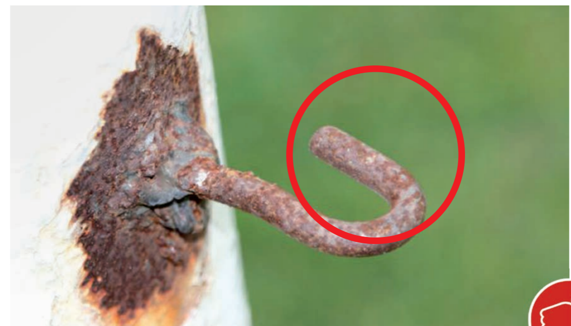
Bild 32a und 32b: Offene Metallnetzaken sind nicht erlaubt.
