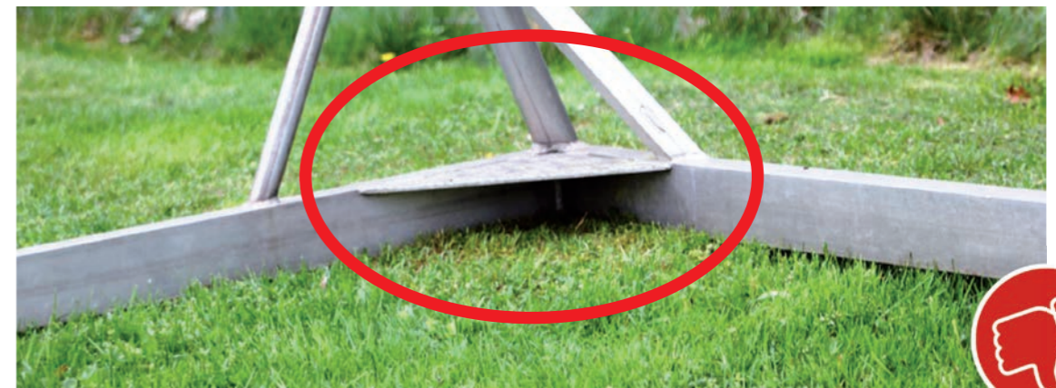
Bild 28: Eingeschweißter Winkel stellt erhöhte Verletzungsgefahr dar
