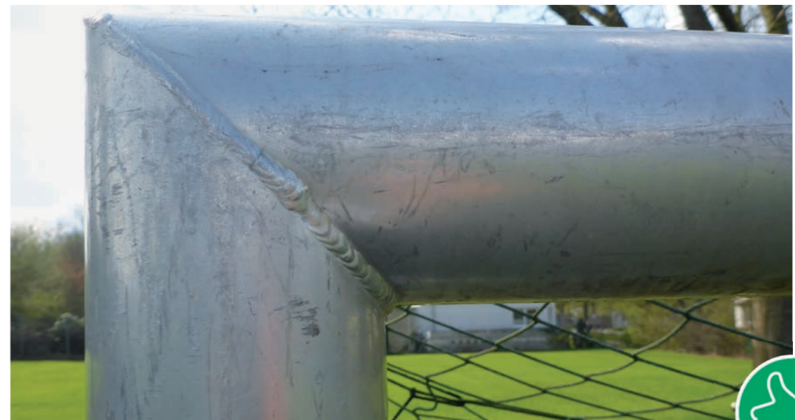
Bild 14: Pfosten und Querlatte haben den gleichen Querschnitt
