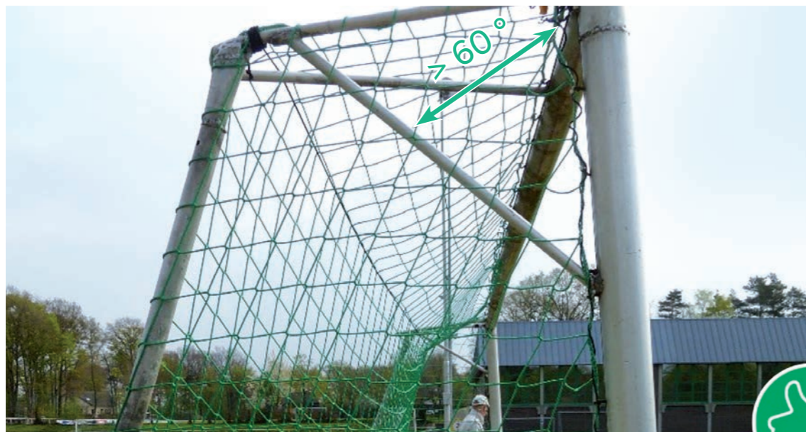
Bild 20: Nach oben geöffnete Winkel müssen > 60^\circ sein
