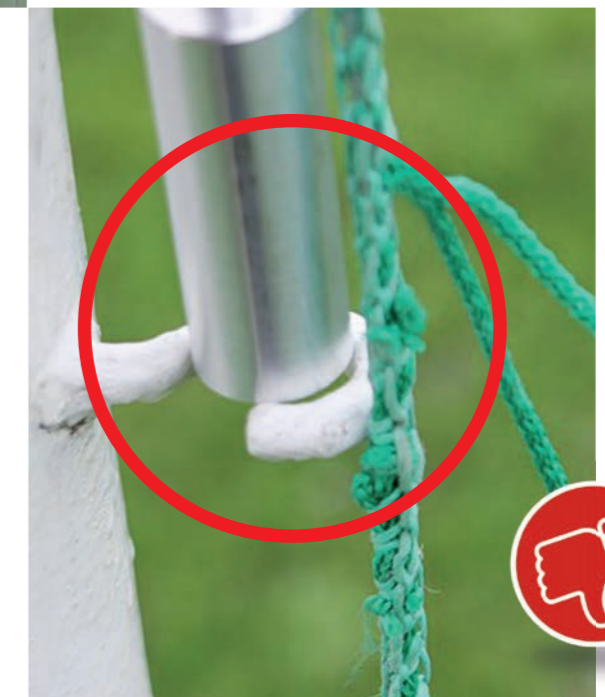
Bild 35: Öffnungen zwischen 8 und 25 mm sind nicht zulässig. Der Prüfstab schafft Klarheit.
